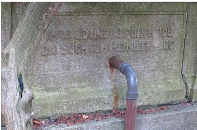
Die dem Busch zugewandte Rückseite des Brunnens war insgesamt deutlich vermoost und die Fugen zeigten keine Verbindung der einzelnen Bauteile des Brunnens mehr. Ebenso war zu erkennen, dass bei der Inschrift zwei Buchstaben des Wortes „Freude“ fehlen, sei es durch Verwitterung oder auch durch mechanische Einwirkungen während der langen Brunnengeschichte.
