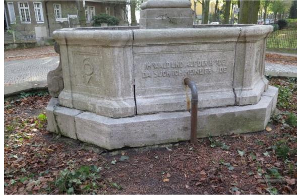
Erfreulicher Weise konnten hierdurch und durch einen weiteren Reinigungsgang mittels eines stärkeren Reinigungsgerätes wesentliche Verschmutzungen und Moose entfernt werden. Der Muschelkalk ist nach mehr als 90 Jahren teilweise durch Flechten und Luftverschmutzungen jedoch so weit geschädigt, dass diese Spuren nicht vollständig zu entfernen sind. Insgesamt war der neue Eindruck jedoch erfreulich!
